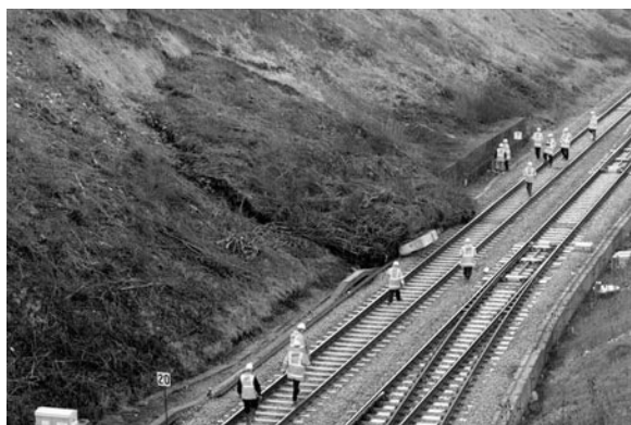
图 1 自然环境下山体滑坡对铁路线路造成严重破坏的示意图
